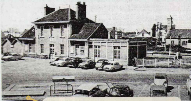
Le pont-bascule de la place de la Gare
