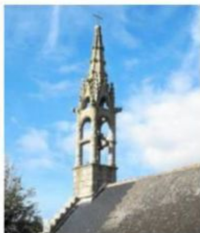
Le clocher de la chapelle de Trémorvézen.
