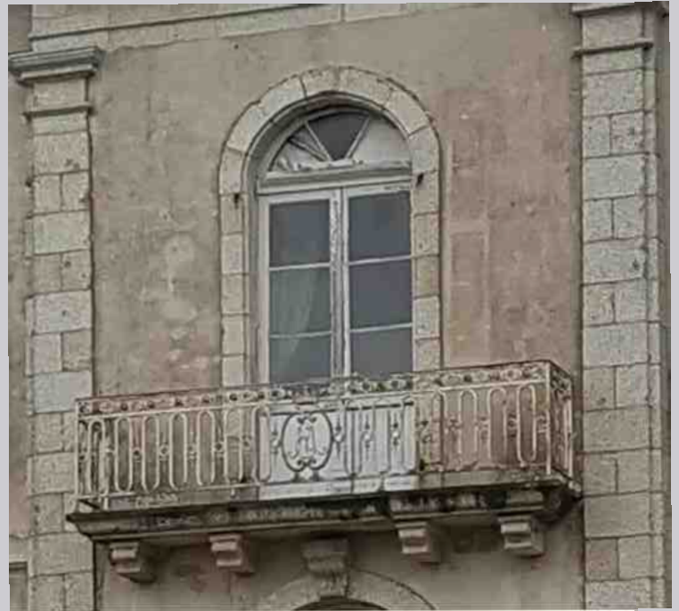
Remarquer les initiales en fer forgé sur le balcon
